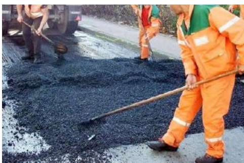
Travaux de voirie à Beauville
