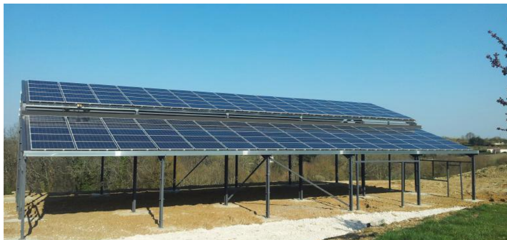
Le bâtiment en construction avec ses 280 m 2 de panneaux photovoltaïques
